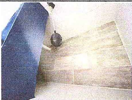
Foto 11: instalación de azulejo en la parte interna del tanque de abastecimiento
