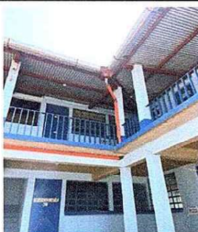
Foto 3: Proceso de instalacion de tubería
