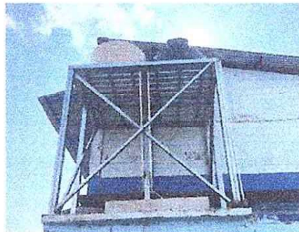
Foto 8: Instalación de 2 tinacos sobre plataforma para distribución de agua.
