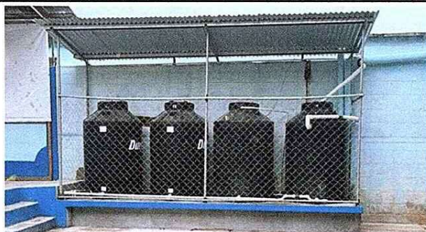
Foto 5: Instalación de tinacos para captación de agua pluvial
