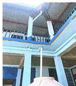
Foto 4: Proceso de conexión de red de tubería para aprovechamiento de vital líquido.
