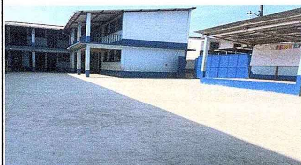
Foto 2: Piso de concreto firme finalizado
