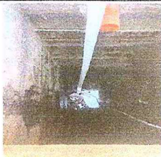
Foto 9: Se observa la limpieza de la fosa séptica en su totalidad
