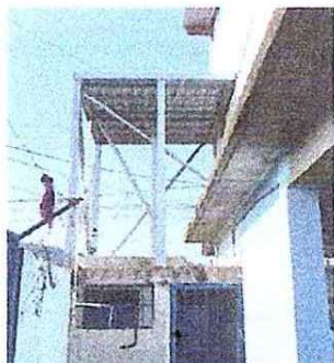
Foto 7: Procesos de reforzamiento de plataforma
