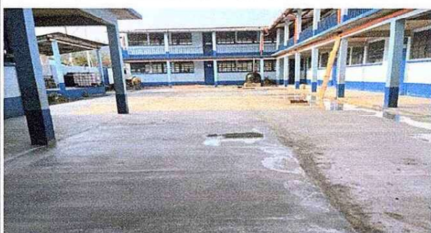
Foto 1: Piso de concreto firme finalizado
